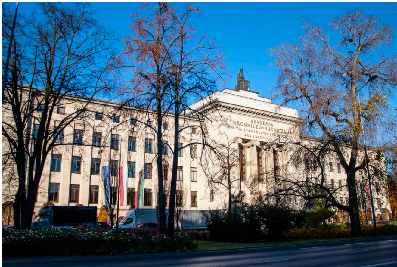
AGH w Krakowie, Budynek A-0, stan obecny: 2021 r., fot. Agnieszka Maślowska, IPN Kraków.
